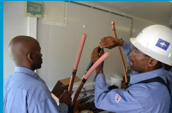
Het verwijderen van de spanningloze halfgeleidende laag.
